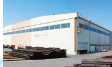
日鉄物流倉庫
