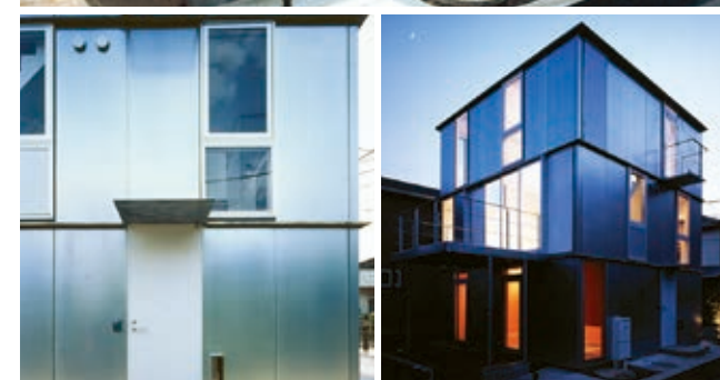
鉄骨3階建て住宅 (外装パネル) ©Hiroyuki Hirai 設計：シゲルヒラキアーキテクト
