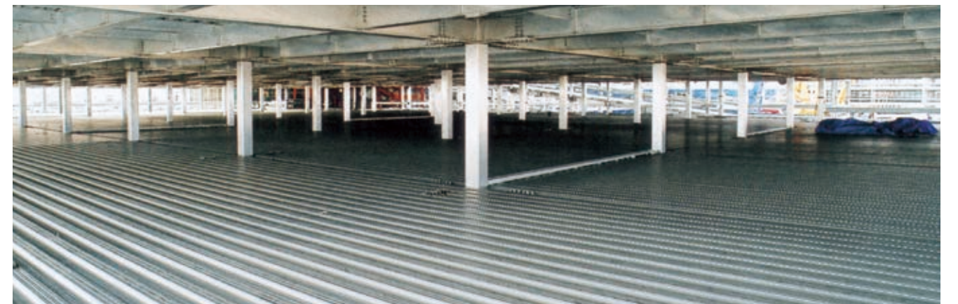
建設中の自走式立体駐車場
