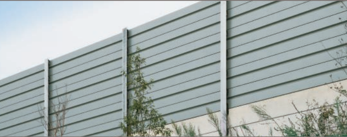
▲ 遮音壁 (ZPG 処理)
