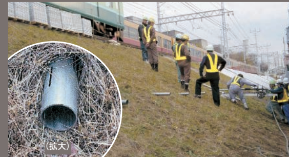
▲ 排水補強パイプ
