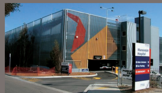
自走式立体駐車場 (全体)
