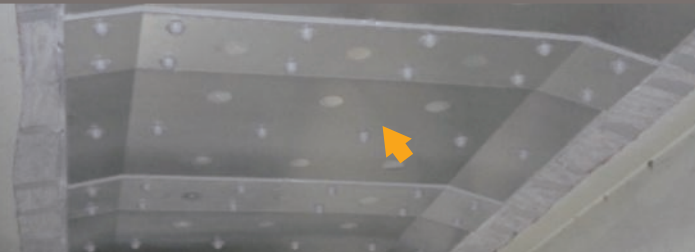
▲ 橋梁補強板(鋼板接着工法) ZAM® ZKS 処理、ZAMグラウト®を適用
