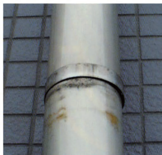
●バンド方式(施工後10年) バンドによるこすれ傷が目立ちます
